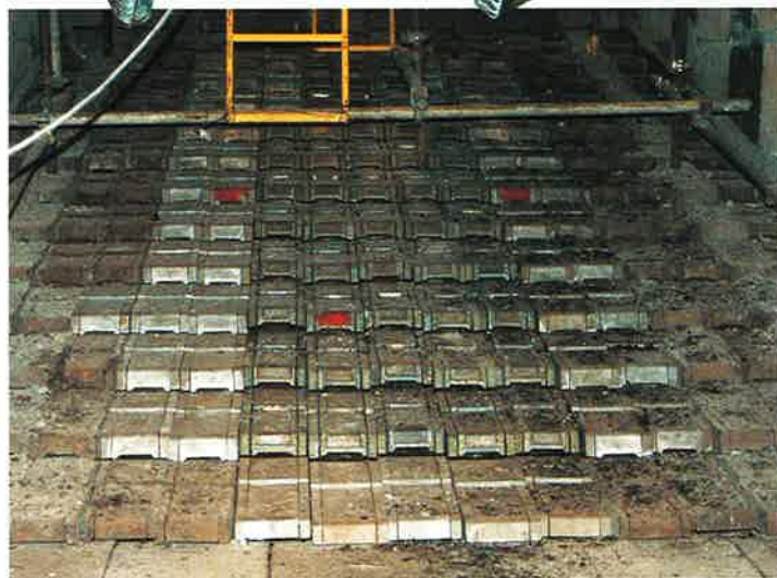
■ ロストル施工
